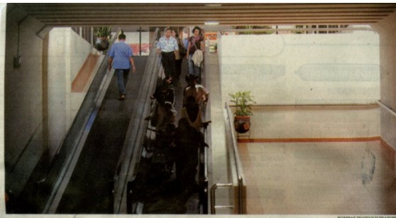
Saat ini para penumpang di Bandara Adisutjipto, Yogyakarta, bisa lebih nyaman karena tidak lagi harus menyeberangi rel dari atau menuju tempat parkir sejak difungsikannya fasilitas underpass , seperti yang terlihat pada Senin (25/8). Underpass yang membentang sekitar 100 meter di bawah jalur kereta api tersebut dilengkapi dengan empat travelator , atau moving walkway (ban berjalan), dan berpendingin udara.
