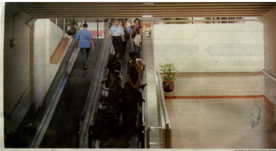
Saat ini para penumpang di Bandara Adisutjipto, Yogyakarta, bisa lebih nyaman karena tidak lagi harus menyeberangi rel dari atau menuju tempat parkir sejak difungsikannya fasilitas underpass , seperti yang terlihat pada Senin (25/8). Underpass yang membentang sekitar 100 meter di bawah jalur kereta api tersebut dilengkapi dengan empat travelator , atau moving walkway (ban berjalan), dan berpendingin udara.
