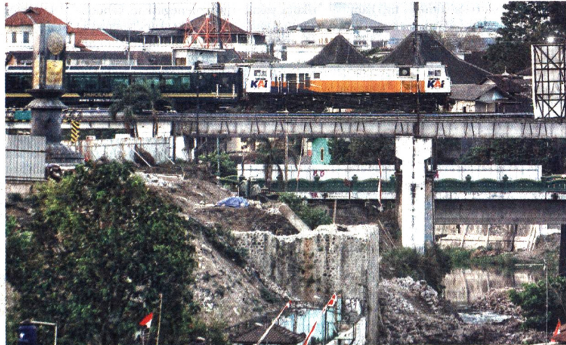
DIKEBUT: Kereta api melintas di jembatan perlintasan kereta api antara Jembatan Kleringan dan Jembatan Kewek yang prosesnya capai 30 persen. Ditergetkan bisa difungsikan sebelum natal tahun ini.
