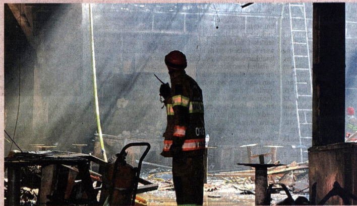
HANGUS - Petugas Damkarmat Kota Yogyakarta sedang berkoordinasi untuk proses pendinginan pascakebakaran di gedung Rama Billiard, Mergangsan, Jumat (3/7).
