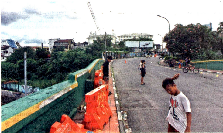
RENOVASI TOTAL: Bocah bermain di Jembatan Kewek Jogja (21/4). Jembatan Kewek akan diganti baru dengan nilai kontrak pembangunan Rp 19 miliar. Proyek ditarget selesai akhir tahun ini.
