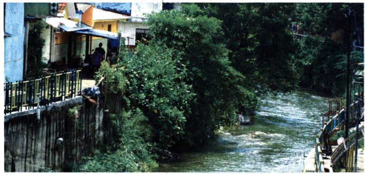
PENATAAN - Kondisi bantaran Sungai Winongo di wilayah Pakuncen, tepatnya di utara Jembatan Serangan, belum lama ini. Pemkot Yogyakarta melanjutkan pembangunan jalan inspeksi di bantaran sungai itu pada tahun ini.
