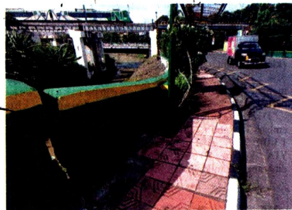
DWI AGUS2006LO JOGJA DOKUMENTASI: Kondisi Jembatan Kewek yang saat ini di tutup total dan akan dilakukan pembangunan ulang.
