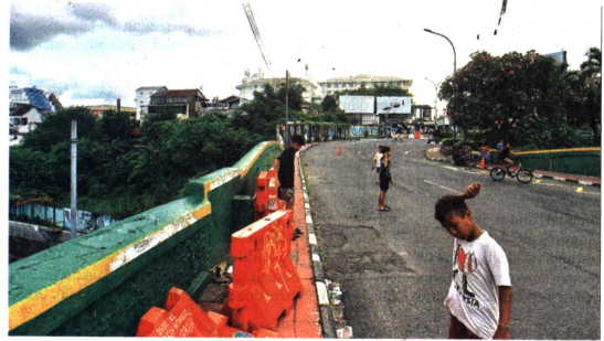
SEGERA DIRENOV: Bocah bermain di Jembatan Kewek, Kota Jogja kemarin (21/4). Renovasi jembatan tersebut akan dimulai pada Mei tahun ini, sekaligus disertai penataan kabel di kawasan tersebut.
