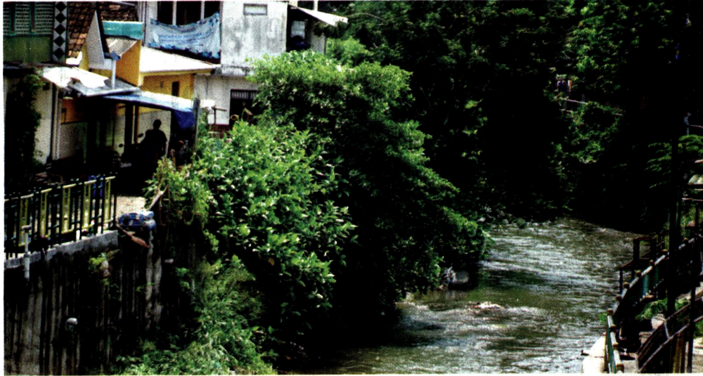
DITATA ULANG: Bantaran Sungai Winongo di wilayah Pakuncen, tepatnya di utara Jembatan Serangan akan dibangun jalan inspeksi sebagai program lanjutan pada tahun ini.
