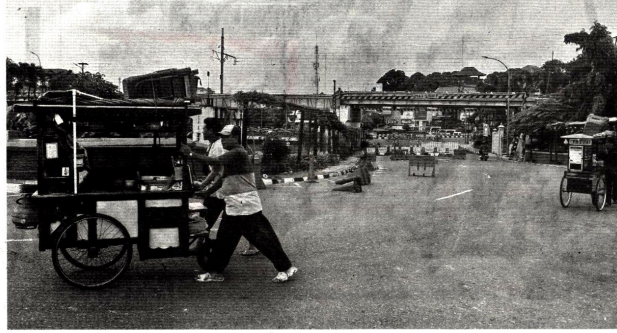
MASIH DITUTUP - Jembatan Kewek yang masih ditutup aksesnya beberapa waktu lalu. Pengerjaan proyek ini mundur Mei, dan ditargetkan bisa digunakan awal 2027. Meski masih proses lelang, pengerjaan ditargetkan selesai delapan bulan.
