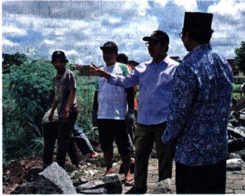
TINJAU LOKASI - Wali Kota Hasto Wardoyo, meninjau lokasi proyek padat karya yang digulirkan Pemkot Yogya pada 2025 lalu.
