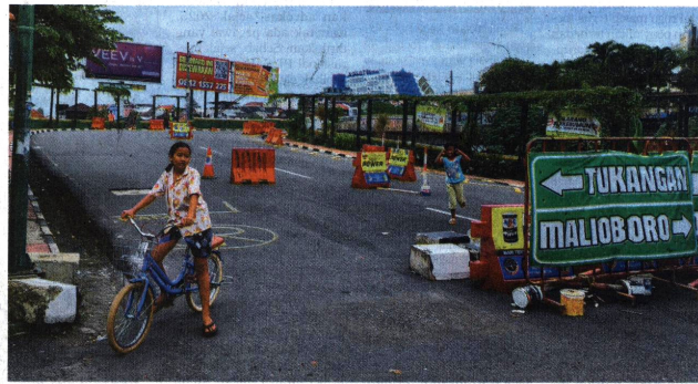
BERMAIN - Anak-anak bermain di atas konstruksi Jembatan Kewek, Kota Yogyakarta, Selasa (24/2). Jembatan tersebut kini ditutup total untuk persiapan pembangunan ulang pada kisaran April 2026 mendatang.
