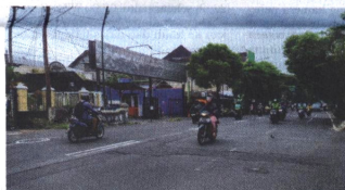
AMBLES - Kondisi ruas Jalan Kusumanegara, Kota Yogyakarta yang dikeluhkan warga gegara ambles di beberapa titik, Senin (23/2).
