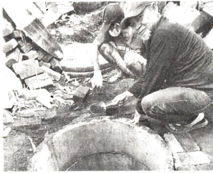
Istimewa/Dok. Kelurahan Cokrodingratan Warga Cokrodingratan memasang bus beton yang digunakan sebagai biopori jumbo sebagai tempat mengolah sampah organik, beberapa waktu lalu.
