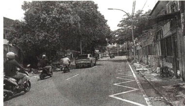
BAKAL HILANG: Deretan kios penjahit dan permak jins di Jalan Dr Sardjito, Gondokusuman, Kota Jogja yang akan dirobuhkan.
