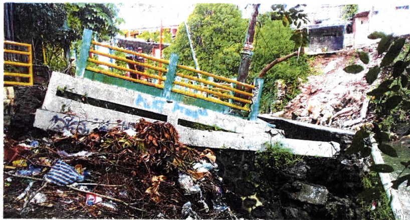
LONGSOR - Kondisi talud yang longsor di kawasan bantaran Sungai Gajah Wong, masuk wilayah Kelurahan Baciro, Kemantren Gondokusuman, Kota Yogyakarta, Minggu (11/1). DOK. BPBD KOTA YOGYAKARTA
