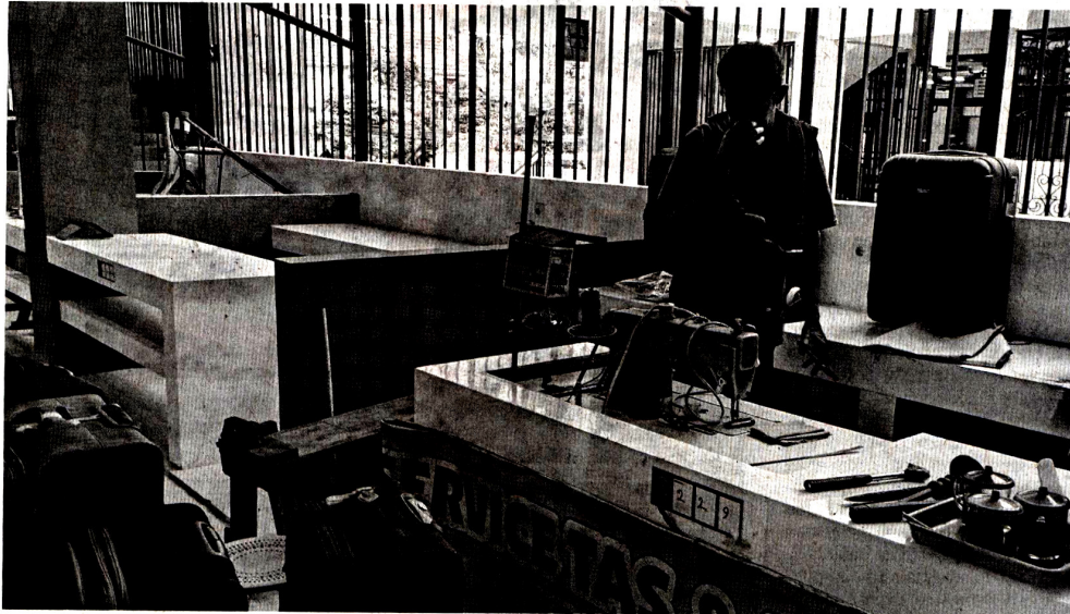
ROMBAK: Pemilik Jasa Servis Tas dan Koper Pak Is Yunus Wahyu saat merenovasi losnya di Pasdr Terban, kemarin (15/1). Los yang disediakan dinilai kurang layak. Pemkot Jogja menyatakan akan mengevaluasi desain bangunan Pasar Terban yang masih berstatus uji coba.
