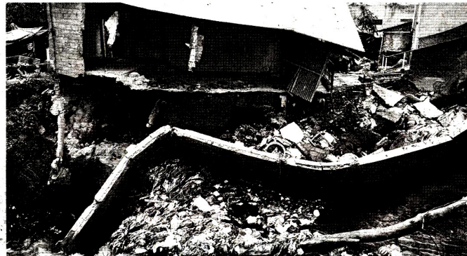
AMBROL: Kondisi talut Sungai Buntung pada Senin (19/2/2026). Talut tersebut ambrol akibat hujan deras pada Sabtu (17/1/2026) lalu. BBWSSO melakukan pemasangan bronjong sebagai penanganan darurat.
