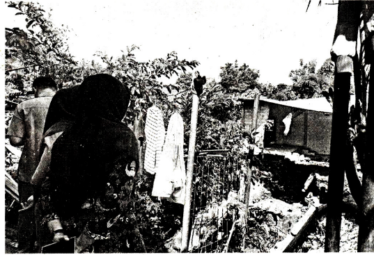
Petugas dari BBWSSO, memantau kondisi talut dan balai RT57/RW13 Bangunrejo, Tegalrejo, yang ambrol diterjang banjir, Senin (19/1).
