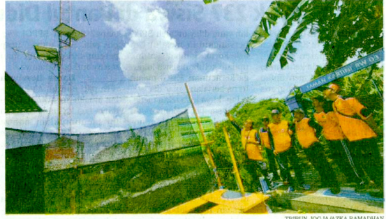
PANTAU EWS - Pemantauan sistem operasional Early Warning System (EWS) Sungai Buntung, yang berlokasi di Kampung Pingit, Kemantren Jetis, Kota Yogyakarta, Selasa (4/11).
