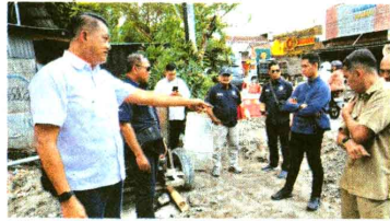
KR-Ardhi Wahdan Jajaran Komisi C DPRD Kota Yogya ketika meninjau pekerjaan saluran air hujan di Jalan Kebun Raya Rejowinangun.
