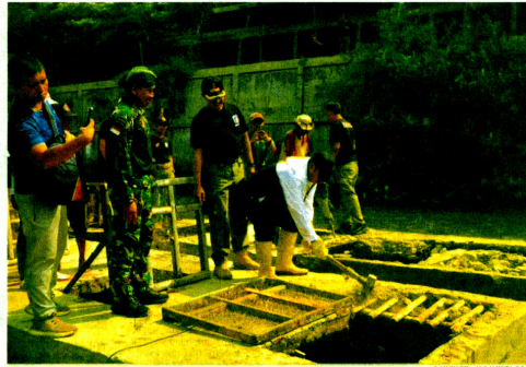
PENATAAN - Wali Kota Yogyakarta, Hasto Wardoyo, turun langsung memimpin kegiatan kerja bakti membongkar keramba-keramba ikan di Sungai Code, Minggu (19/10).
