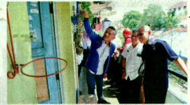
KR-Achi Wahdani Pansus Raperda Rusun DPRD Kota Yogya meninjau kondisi Rusun Cokrodirjan.
