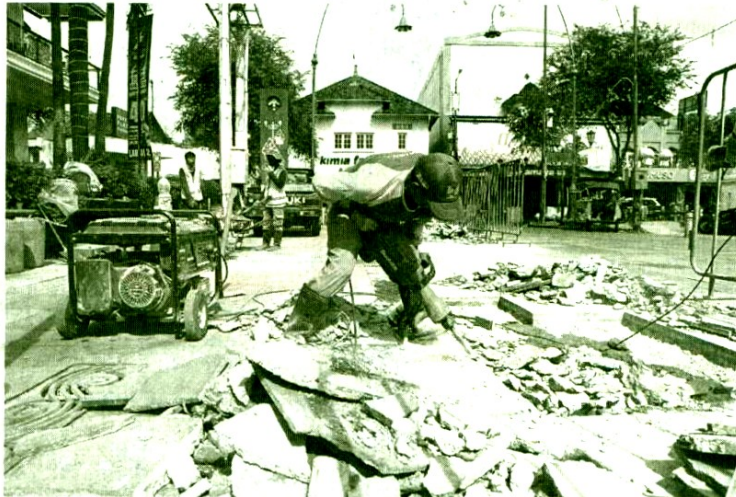
PERAWATAN: Pekerja menyelesaikan proses perbaikan Jalan Perwakilan, kawasan Malioboro, Jogja, kemarin (17/9).
