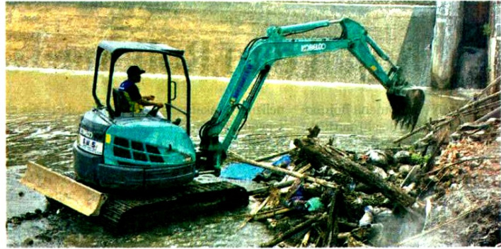
DINORMALKAN: Alat berat dikerahkan untuk mengeruk sedimentasi Sungai Code saat program normalisasi sungai di Bendung Mergangsan, Kota Jogja, kemarin (24/8).
