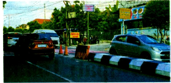
DEVIDER PORTABEL - Sepenggal batas jalan di Jalan Abu Bakar Ali yang dibongkar dan diganti devider portabel untuk memudahkan akses masuk bus ke lahan parkir eks Menara Kopi, Kotabaru, Yogyakarta. Pemkot Yogya memastikan pembongkaran Tempat Khusus Parkir (TKP) Abu Bakar Ali (ABA) tidak jadi kendala berarti di libur sekolah kali ini.
