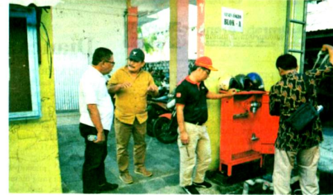
Pemeriksaan jaringan hidran di Rusunawa Cokrodirjan.
