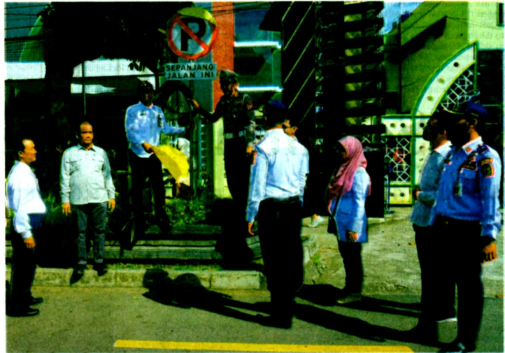
PEMASANGAN RAMBU - Pemasangan rambu larangan parkir di sisi barat Jalan Kapas, Kemantren Umbulharjo, Kota Yogyakarta, Rabu (11/5).
