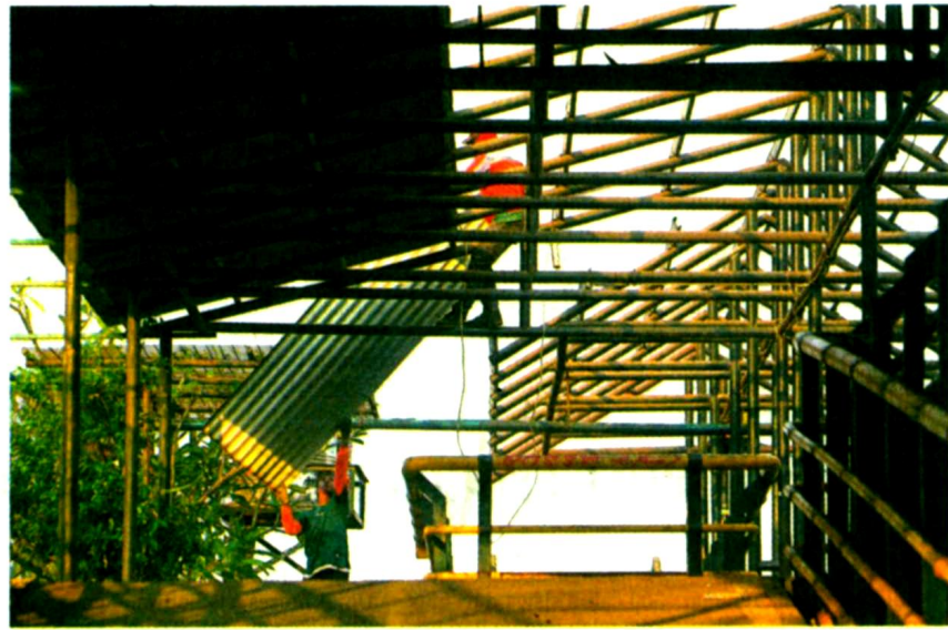
DICOPOT: Pekerja saat mulai mencopot bagian atap lantai tiga Tempat Khusus Parkir (TKP) Abu Bakar Ali, Kota Jogja kemarin (2/6). Pemrov DIJ melalui Dishub DIJ telah memulai proses pembongkaran.
