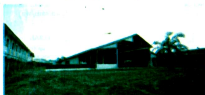
RELOKASI: Kondisi bangunan eks Menara Kopi di Kotabaru, Yogyakarta.
