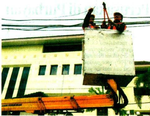
DIATAS: Wali Kota Yogyakarta Hasto Wardoyo menaiki crane untuk merapikan kabel di kawasan Sumbu Filosofi, kemarin.
