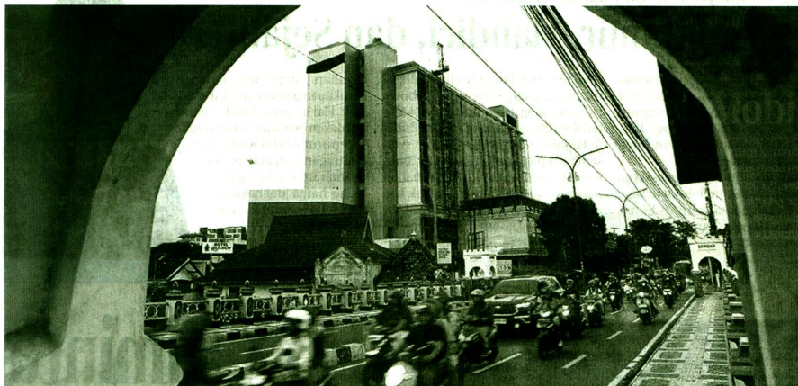
KOKOH: Proyek pembangunan gedung bertingkat di Jalan Sultan Agung, Kota Jogja, kemarin (24/4). Sekitar 1500 permohonan PBG 2024 hingga sekarang belum terselesaikan.
