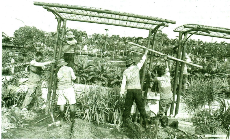
AGAR LEBIH INDAH: Pergola tanaman di kawasan Jalan Kleringan dekat Jembatan Kewek, Kota Jogja, dipasang kembali setelah diperbaiki guna menunjang keindahan kawasan perkotaan. Pergola lama sudah berumur lebih dari 12 tahun.
