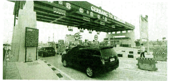
MERAPI-ANTARA FOTO/Abiyus Jarot Nugroho Pengemudi melintas di jalan tol Klaten-Prambanan di Gerbang Tol Prambanan, Klaten, Jawa Tengah, Senin (24/3). PT Jasamarga Jogja Solo mengoperasikan segmen jalan tol Klaten-Prambanan secara fungsional sepanjang 8,6 Km yang dibuka 24 jam untuk semua golongan kendaraan dari tanggal 24 Maret hingga 7 April guna mendukung kelancaran arus mudik Lebaran.
