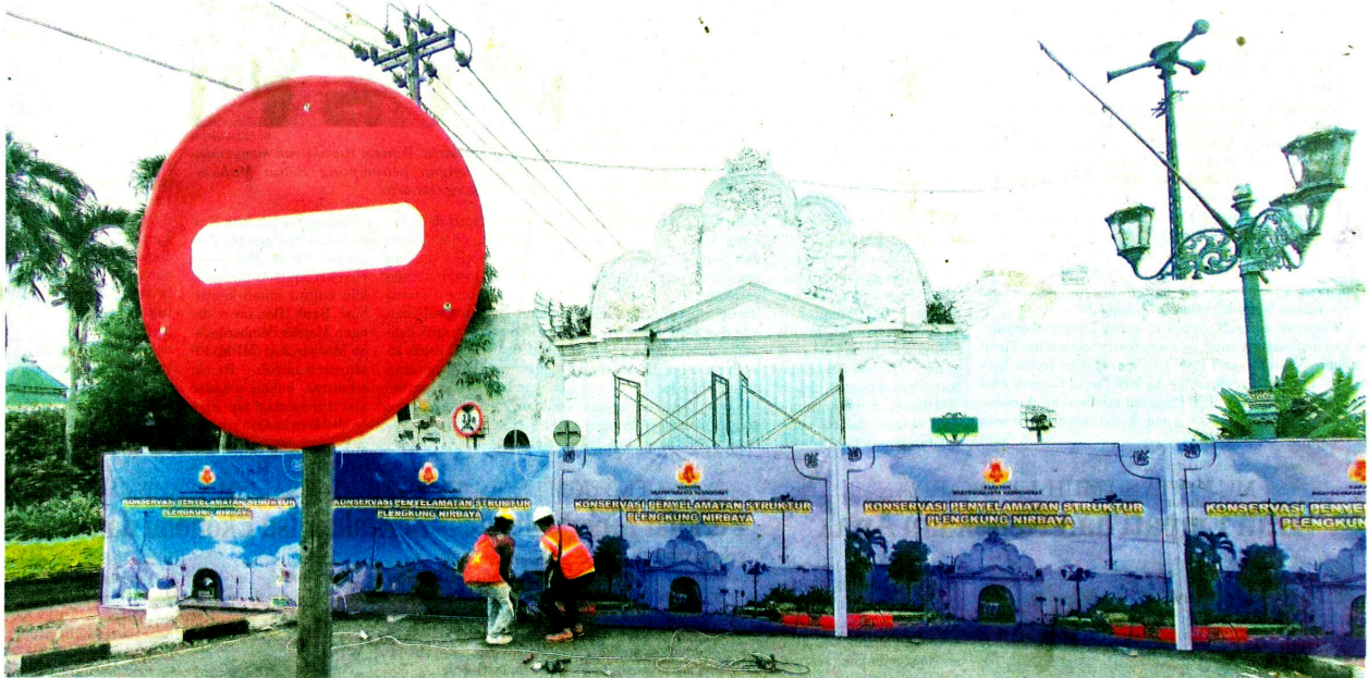
Plengkung Nirbaya atau Plengkung Gading mulai Sabtu (15/3) ditutup total. Penutupan tersebut atas dasar terlihatnya indikasi dampak yang muncul akibat tekanan usia struktur, pembangunan dan lingkungan.
