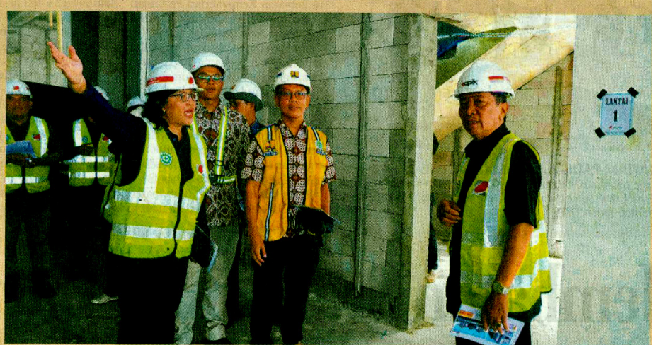
TINJAU PROYEK - Jajaran Pemkot Yogya dan BPPW PUPR DIY saat meninjau proyek revitalisasi Pasar Terban, Jumat (7/2). Istimewa/DOK. PEMKOT YOGYA
