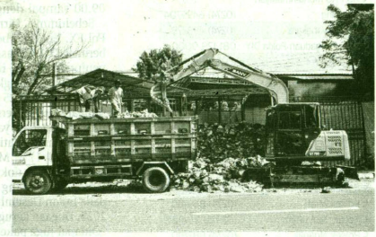
Sejumlah alat berat dikerahkan untuk membersihkan timbunan sampah di depo yang ada di wilayah Kota Jogja belum lama ini.
