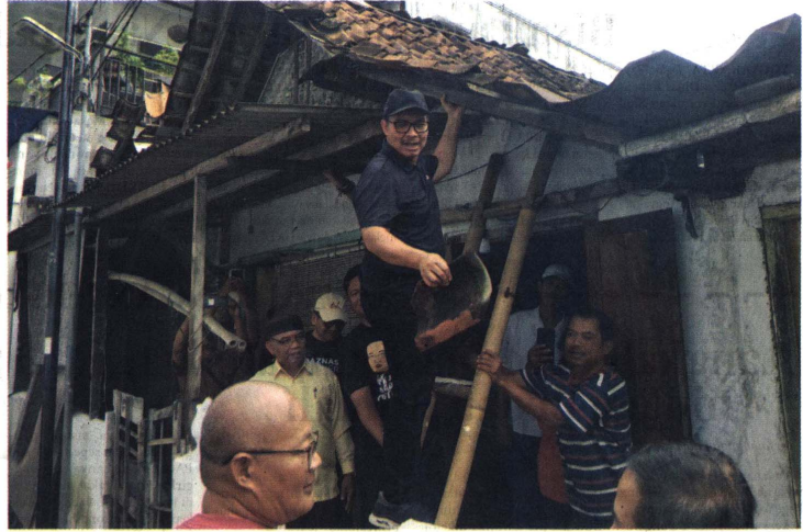
RENOVASI: Wali Kota Yogyakarta terpilih dr. Hasto Wardoyo menurunkan genteng rumah yang akan direnovasi.
