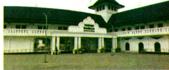
SELESAI: Taman Budaya Embung Giwangan merupakan salah satu dari 10 Proyek Strategis Kota Yogyakarta telah selesai dibangun.
