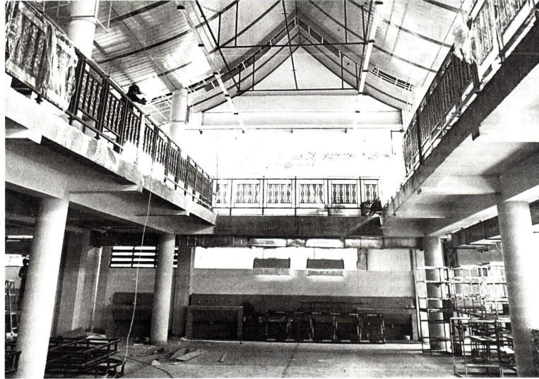
Kondisi terkini gedung Teras Malioboro 2 yang terletak di kawasan Ketandan, seperti terlihat belum lama ini. Lokasi ini nantinya menjadi lokasi permanen bagi pedagang yang saat ini masih berada di seller Teras Malioboro 2.
