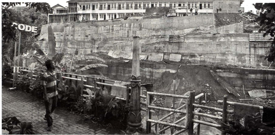
PROYEK STRATEGIS: Pekerja menyelesaikan proyek penataan permukiman kumuh Kelurahan Terban, Kota Jogja, kemarin (16/12). Pemkot Jogja melalui PUPKP tengah mengebut pengerjaan empat dari sepuluh proyek strategis yang belum terselesaikan. Seluruhnya proyek ditarget akan selesai pada bulan ini.
