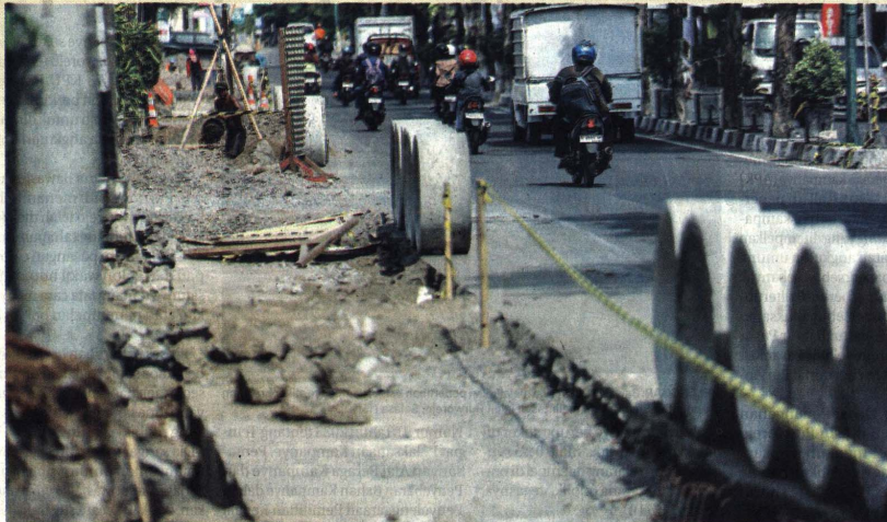
SEGERA DIRAMPUNGKAN: Pengendara motor melintasi proyek perbaikan drainase di kawasan Bener, Tegalrejo, Jogja, Senin (14/10). Banyak masyarakat mengeluh soal rumitnya birokrasi pemerintahan. Seperti proyek pembangunan drainase di sebuah wilayah yang harus segera dikerjakan karena akan memasuki musim penghujan.
