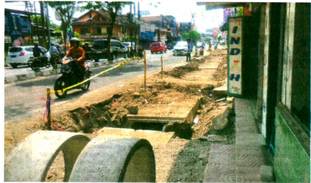
MOLOR - Kondisi proyek pembangunan drainase di Jalan Kyai Mojo, Kota Yogyakarta, Senin (14/10) yang tak kunjung selesai.
