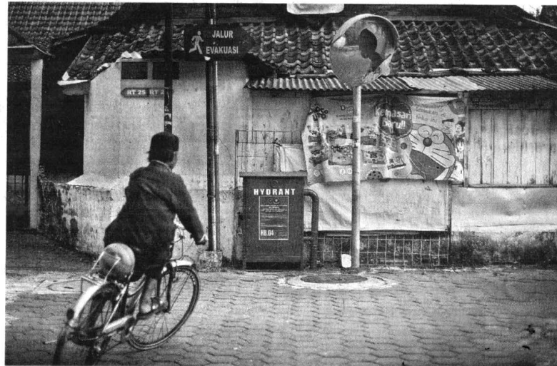
FASILITAS PENTING: Warga melintas di dekat hidran kampung di wilayah Ronodigdayan, Danurejan, Kota Jogja, kemarin (29/7). Keberadaan hidran kampung sebagai sarana untuk memadamkan api apabila terjadi kebakaran di wilayah-wilayah perkampungan padat penduduk dan aksesnya sulit, tergolong masih minim karena keterbatasan anggaran.
