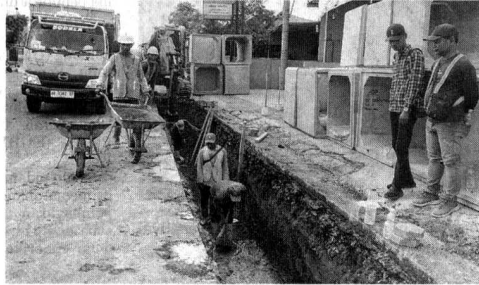
MERAPI-Dok Pemkot Yogyakarta Pemeliharaan berkala Jalan Gedongkuning dalam tahap pengerjaan saluran drainase di sisi timur jalan.
