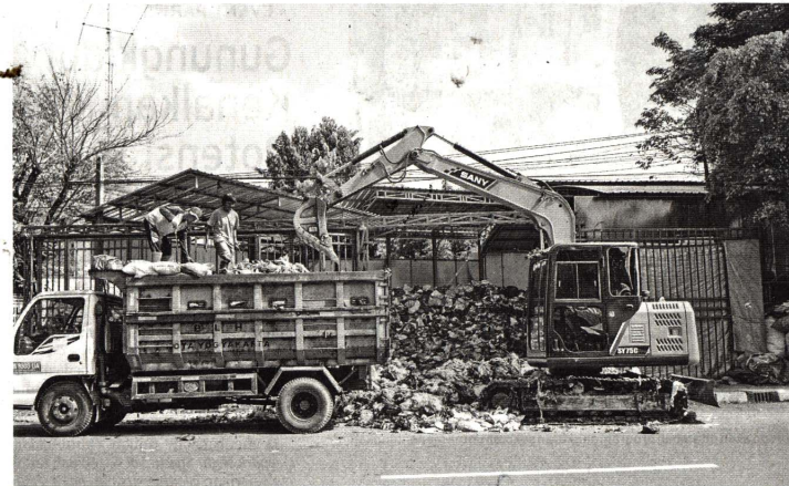
Alat berat jenis ekskavator dioperasikan untuk mengeruk dan mengangkat sampah ke bak truk, Selasa (25/5). Sampah tersebut selanjutnya dibuang ke TPST Piyungan.
