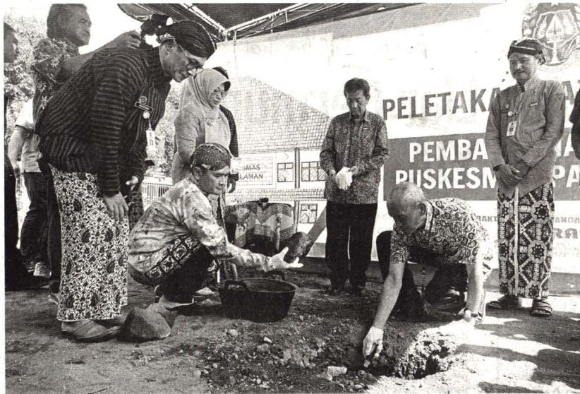
Acara peletakan batu pertama menandai pembangunan gedung baru Puskesmas Pakualaman, Jumat (7/6).
