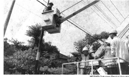
Pencabutan tiang kabel fiber optik di Jalan Ijda Tut Harsono menggunakan kendaraan crane.
