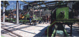
FASILITAS - Pemkot Yogyakarta kini tengah menggebut pembangunan TPST 3R Karangmiri dan Kranon untuk mengatasi persoalan sampah.
