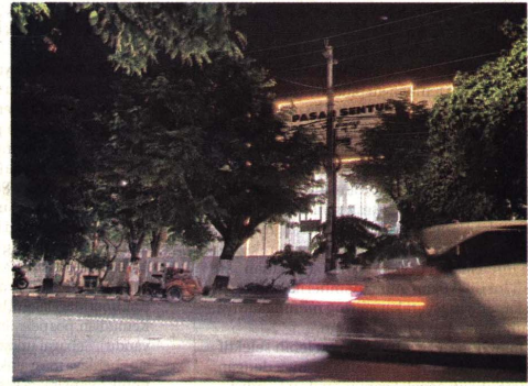
EKONOMI RAKYAT: Renovasi Pasar Sentul Pakualaman merupakan salah satu infrastruktur strategis yang dibangun menggunakan dana keistimewaan DIY di Kota Yogyakarta.
