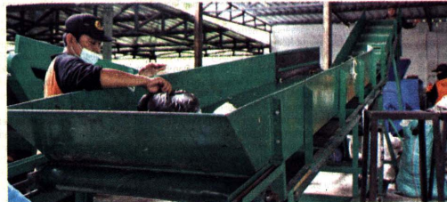
SUDAH Beroperasi: Tempat Pengelolaan Sampah Terpadu (TPST) Nitikan, Umbulharjo, Yogyakarta, dilengkapi empat mesin gribik. Fungsinya memilah sampah rumah tangga organik dan anorganik.
